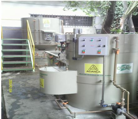
Estação de tratamento de efluentes **CIPAM**, é fabricado totalmente em polipropileno ou em aço carbono, com capacidade para atender até 100 m<sup>3</sup>/h.
