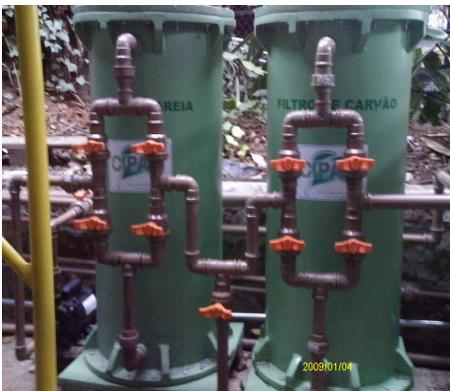
Filtro de areia ou carvão **CIPAM** é fabricado em polipropileno ou aço carbono, tem a capacidade para atender até 80m<sup>3</sup>/h.
